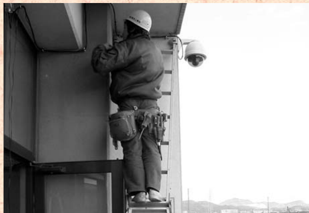
防犯カメラ設置中(大口北部中学校)
