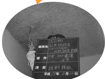
アスベスト撤去工事 1539万円 役場庁舎内のアスベストを撤去
