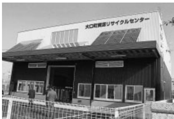
完成した資源リサイクルセンター。場所は総合運動場の南側 =3月28日、竣工式に撮影
