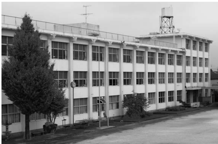
耐震診断の結果で、補強工事が建て替えのどちらを選択すべきか検討される＝大口南小学校の校舎
