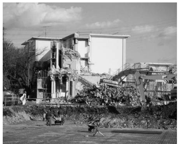
アスベスト除去後、解体されコンクリート片になった西館校舎＝平成18年12月
