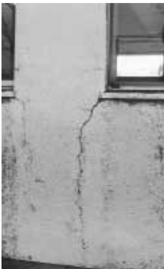
南小学校の校舎のひび割れ状況 = 土田議員の一般質問での提出資料より
