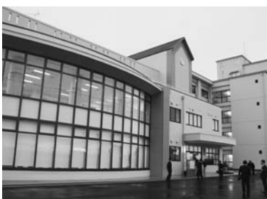
増築部分の北小学校校舎
