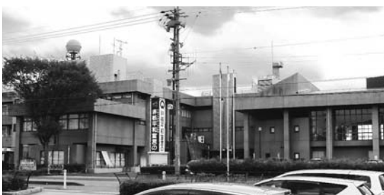
対策が必要な中央公民館
