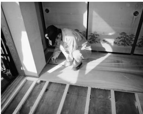
床張替えの住宅改修
