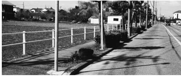
工事が予定されている町道大口桃花台線=大屋敷地内で
