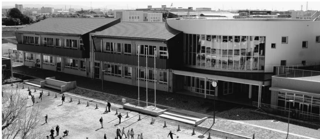
3月14日の竣工日に校舎を撮影
