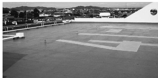
役場庁舎の屋上
