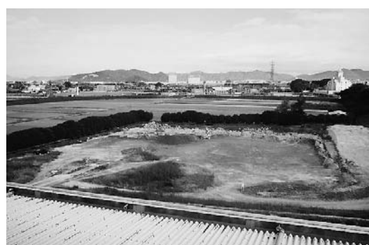
江南丹羽環境管理組合美化センターの最終処分場
