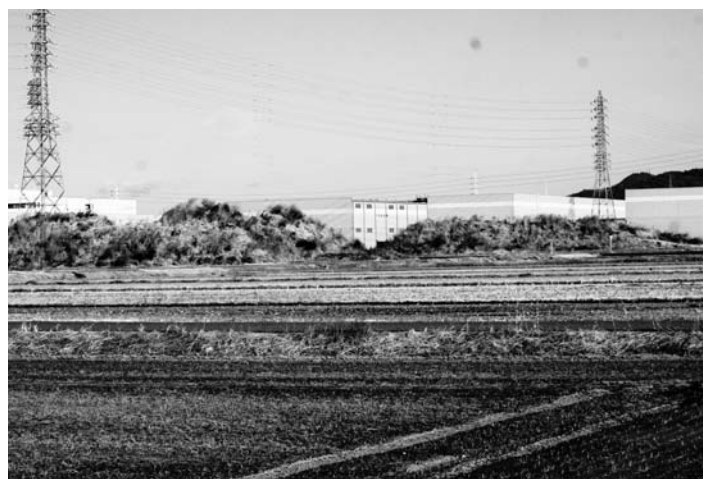
下小口地区の掘削残土の山
