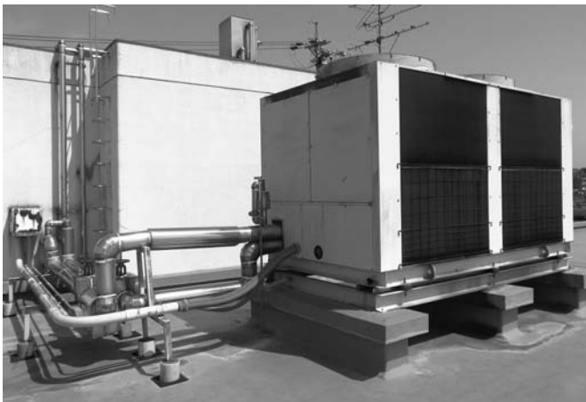
南保育園舎屋上にある老朽化した空調機
