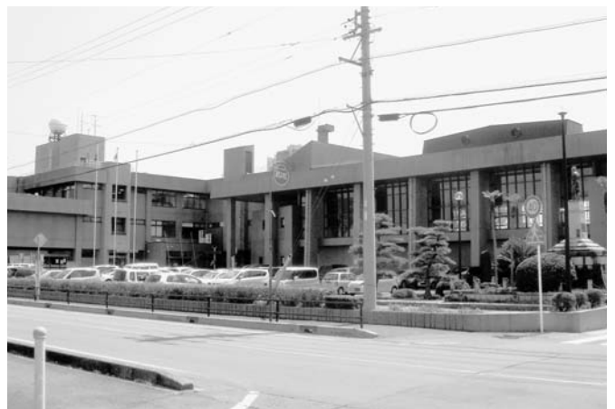
耐震補強工事の設計委託する中央公民館
