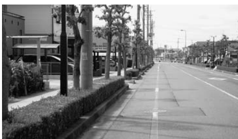
きれいに清掃された町道小口線(余野地内)
