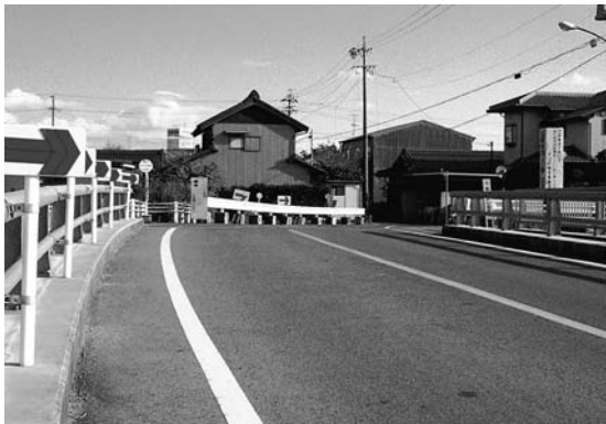
広い大之瀬橋からみた東側の狭い道路
