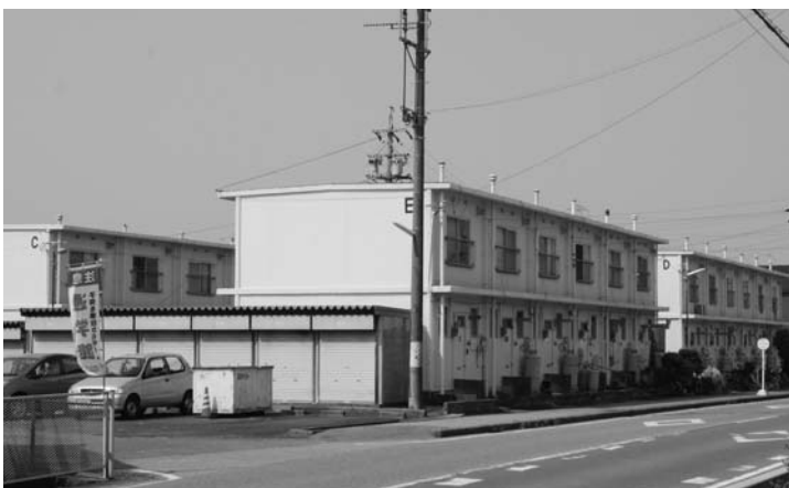
老朽化した植松住宅（築45年）
