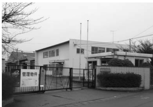
閉鎖された工場（上小口地内）
