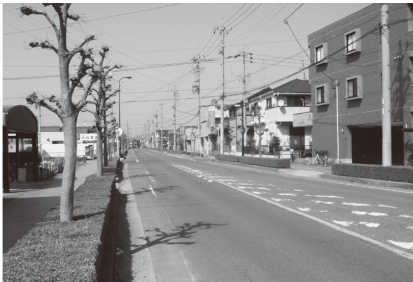
道路舗装工事予定の町道小口線(余野地内)
