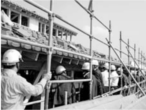
H27/10/23 園舎 屋根工事(県内地場産業の三州瓦で施工)
