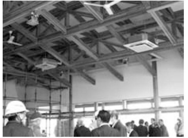
H28/1/29 遊戯室 天井(間伐材を利用した木造で施工)
