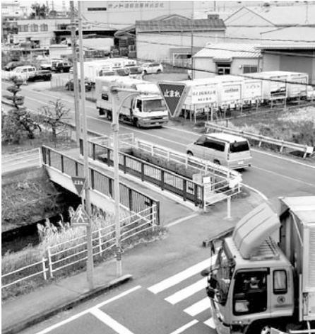
大型車の交通量も多い雉子野橋
