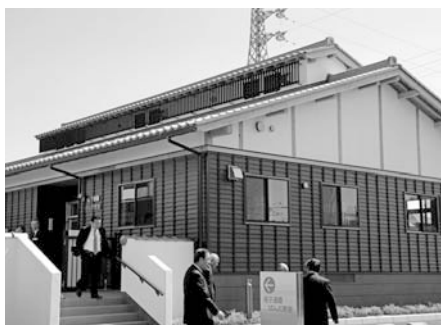
北保育園は2期工事へ
