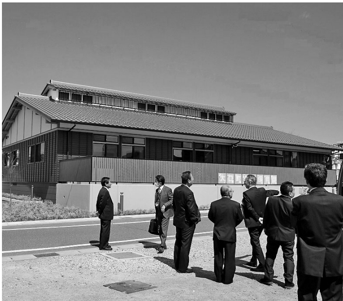
第1期工事完了時の北保育園
