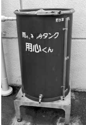
洪水の軽減、防災対策にも役立つとされる簡易貯留施設（雨水タンク） ＝役場庁舎玄関横
