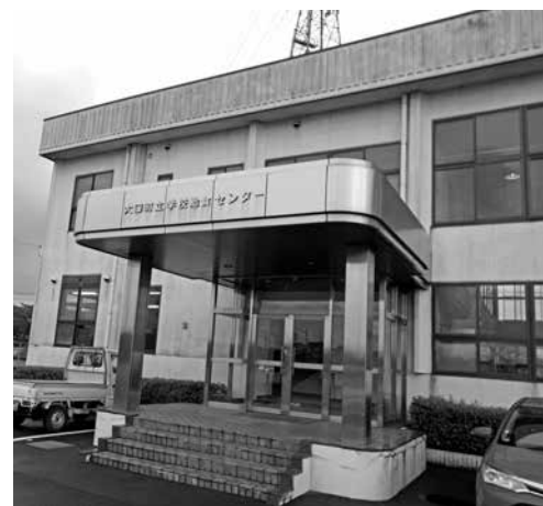
厨房設備などは計画的に入れ替えてはいるが
