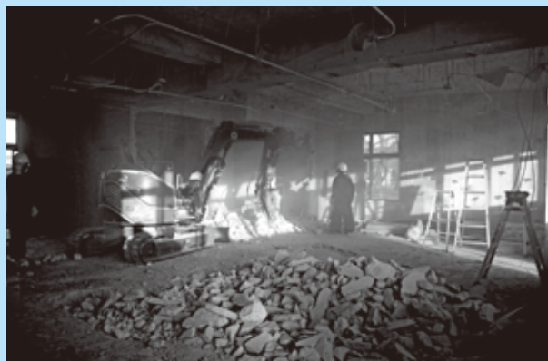
12月14日 工事中の室内には重機が
