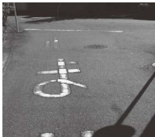
消えかかっている「止まれ」の道路標示
