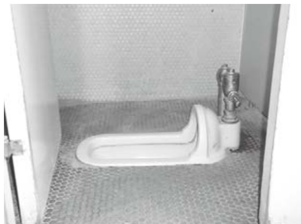
改修が望まれる西小のトイレ
