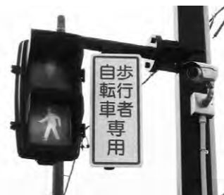
交通事故の状況確認で使われることもある防犯カメラ
