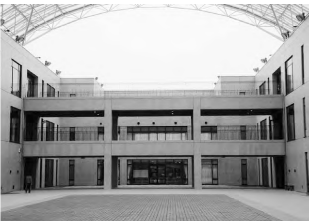
廊下の改修も学習環境の改善の一つ
