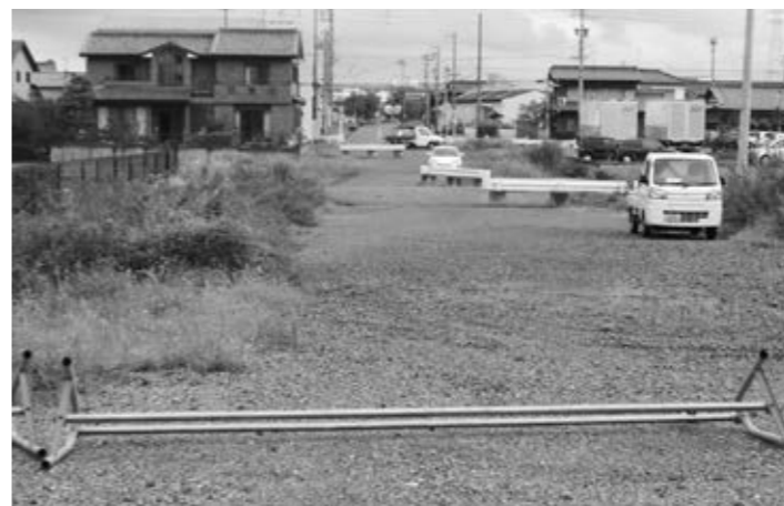
現在の愛岐南北線の様子（堀尾跡一丁目地内）
