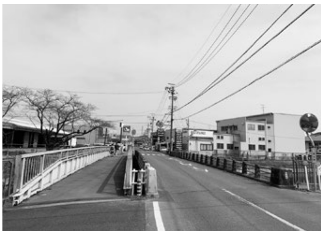
架け替えにより安全性の向上も期待されます
