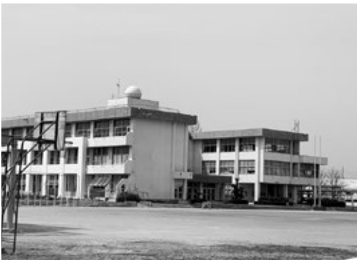
校舎の長寿命化に向けて設備更新等が予定される西小学校
