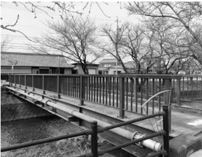
計画的な橋の修繕が行われます
