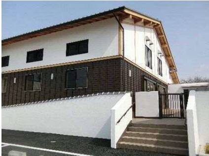
遊戯室の外観
