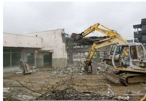
解体される遊戯室
