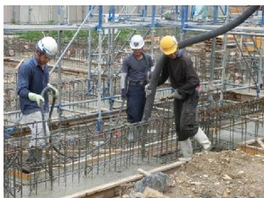
コンクリートポンプ車で遠い所にもコンクリートを流し込み基礎を作っていきます
