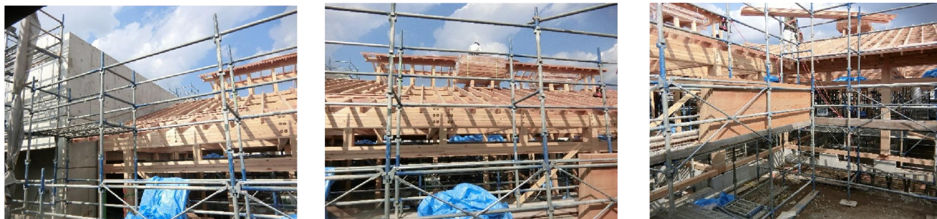
岐阜県美濃市の“うだつ”を参考に、火災の延焼を防ぐために造られたコンクリート造りのトイレと木造保育室
