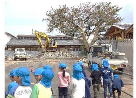
基礎部分もきれいに解体されました
