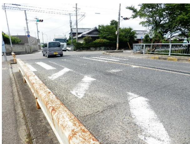
横断歩道や停止線が 消えかかっており危険
