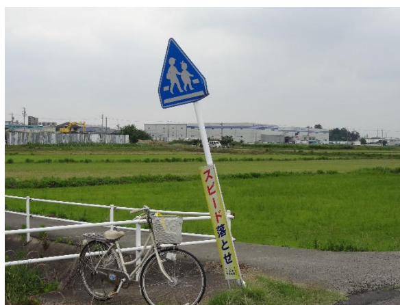
道路標識が傾いている
