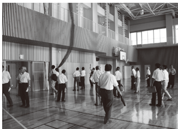
屋内運動場の床下には空気の通り道がある
