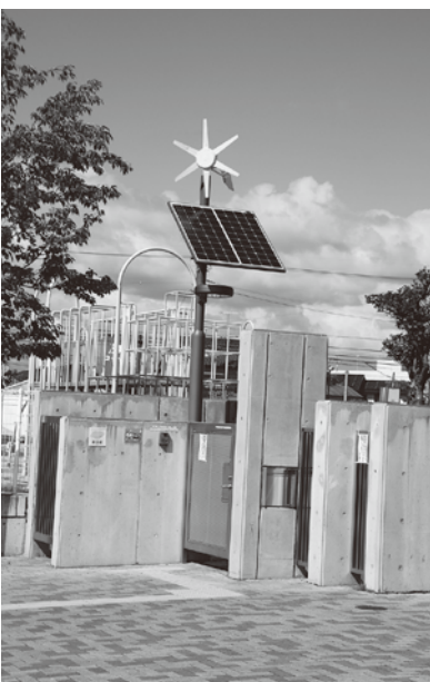
南小学校の風力発電付外部照明(LED)
