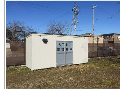
既設防災倉庫移設
