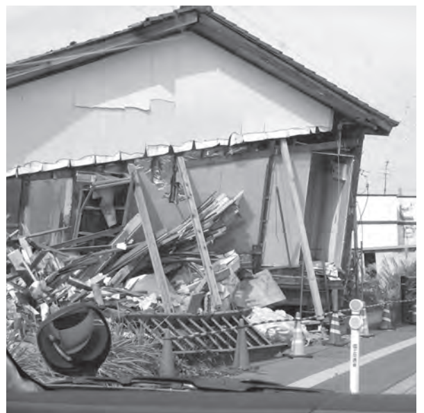
平成19年新潟県中越沖地震により（新潟県柏崎市市内）
