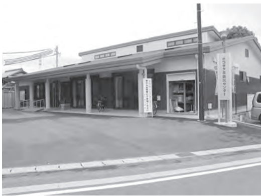
▲さつきヶ丘防災センター
