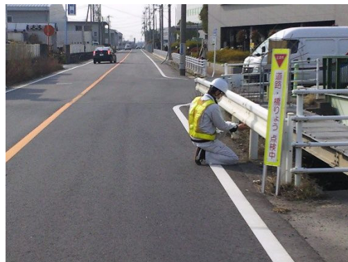
写真-3.4 道路パトロール状況②
