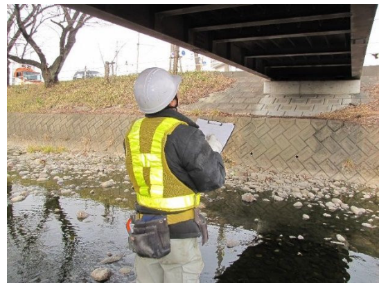
写真-3.2 専門業者による点検状況②
