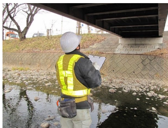
写真-3.2 専門業者による点検状況②
