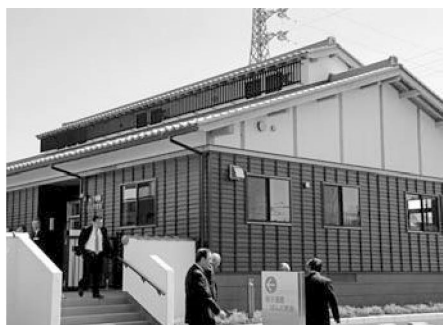
北保育園は2期工事へ
